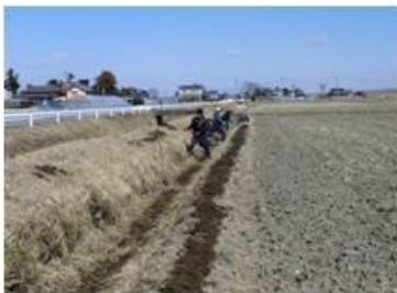
開水路の泥上げ
