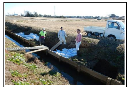
(水路敷の補修)
