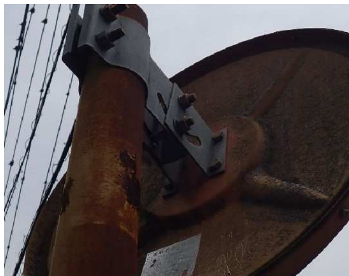
裏面が全体的に腐食している
