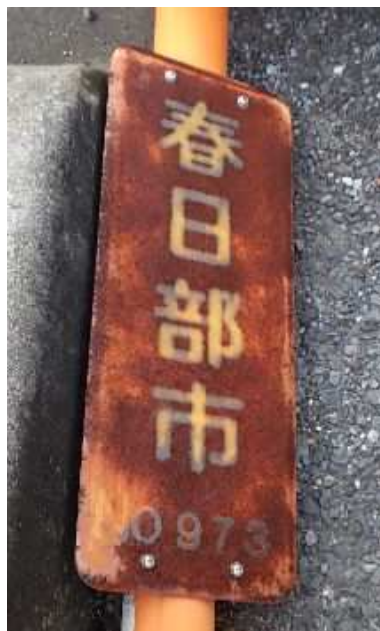
全体的に看板が錆びている
