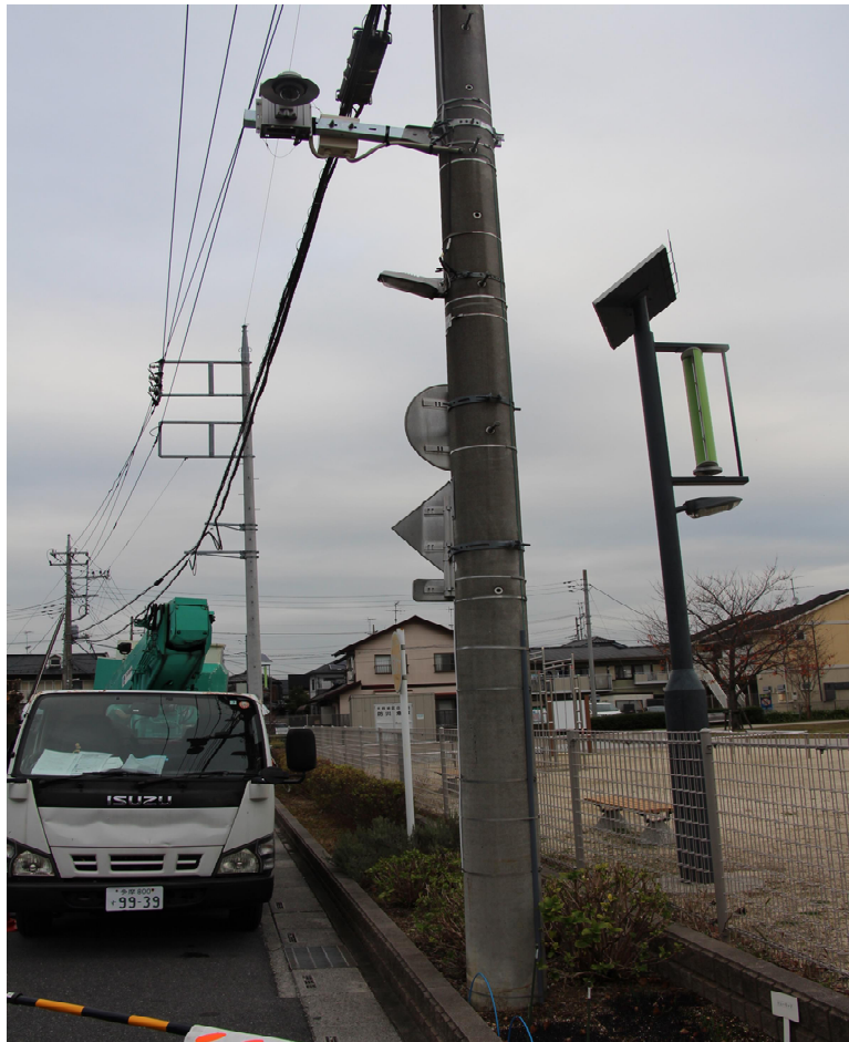
点検写真貼付 (設置状況)
