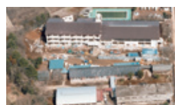
▲建設中の新校舎(昭和63年)
