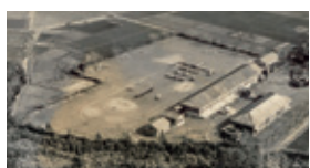
▲宝珠花小学校全景(木造校舎)(昭和37年)
