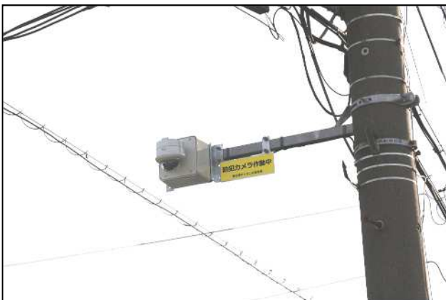
令和6年度に設置した防犯カメラ
