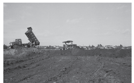
造成中の春日部駅西口の様子 写真右後方に春日部駅を望む。
