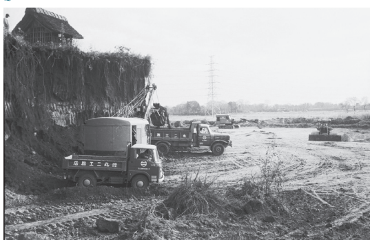
花積地区(住吉台)での土壌の採取の様子 台地を削り大量の赤土が採取されました。
