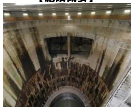
内径最大31.6m、深さ70mの縦穴 第一立坑
