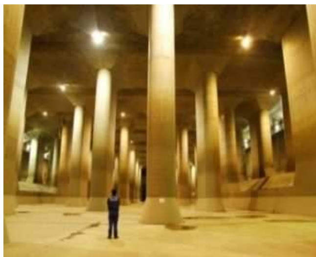
長さ177m、幅78m、高さ18m59本の柱が立ち並ぶ調圧水槽（地下神殿）
