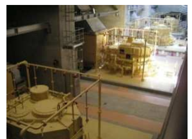
4台のポンプで、25mプールの水を約1秒で排水（最200m 3 /s）
