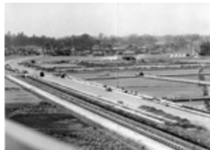
◀昭和44年建設中の旧庁舎から見た風景
