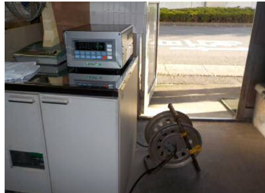
計量機システムにケーブル接続
