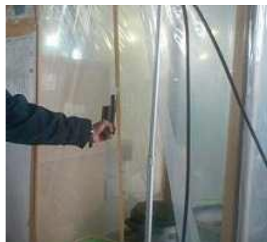
図 4-12 セキュリティゾーンの入口の気流方向の確認（参考：出典 1 P218）
