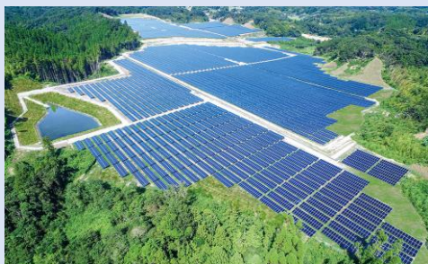
物件名：リエネRJ南九州太陽光発電所 定格容量：26MW
