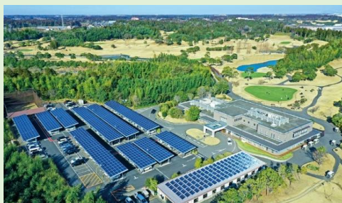
物件名：リエネ芝山ゴルフ倶楽部太陽光発電所 定格容量：450kW
