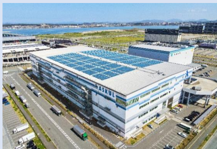
物件名：リエネLOGI'Q福岡太陽光発電所 定格容量：600kW
