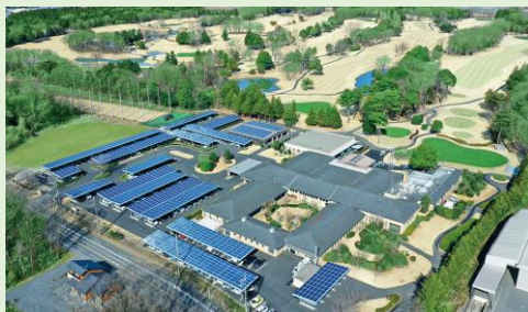
物件名：リエネ猿島カントリー倶楽部太陽光発電所 定格容量：610kW
