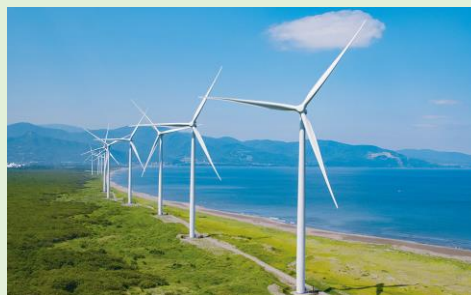
物件名：リエネ銭函風力発電所 定格容量：34MW
