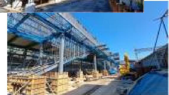
伊勢崎線上りホーム設置工事、南北連絡通路工事
