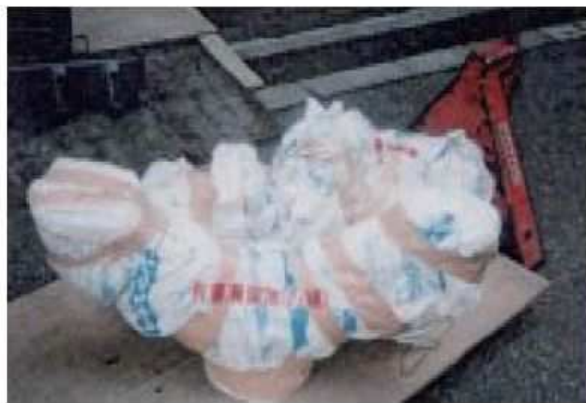
図 4-17 除去した石綿含有保温材配管を梱包し、廃石綿等として処理した例
