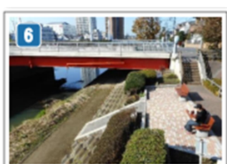
公園橋アンダーパスと休憩スペース (橋の下をくぐれます)
