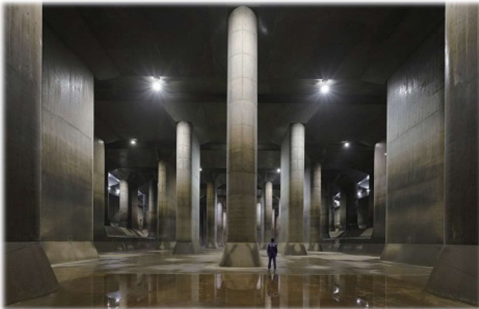
提供元：国土交通省 関東地方整備局 江戸川河川事務所
