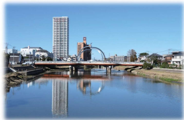
【古利根公園橋】
