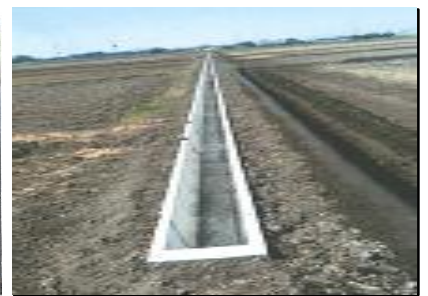
(コンクリート水路への更新)
