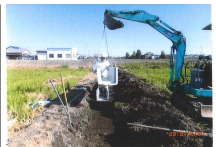
(水路敷設工事 )
