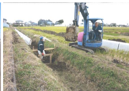
( 水路敷設工事 )
