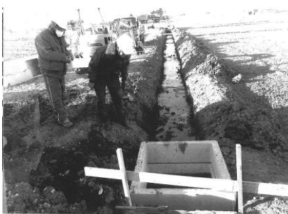
( 水路敷設工事 )
