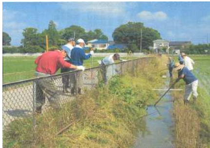
( 水路の泥上げ )
