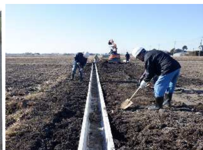
(コンクリート水路への更新)
