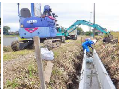
( 水路更新工事 )
