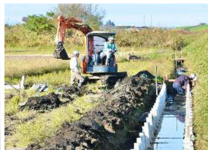
( コンクリート水路への更新 )
