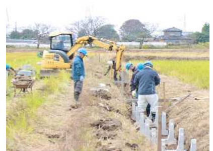
( 水路敷設工事 )
