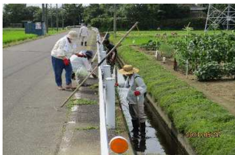
(コンクリート水路の泥上げ 川端南)
