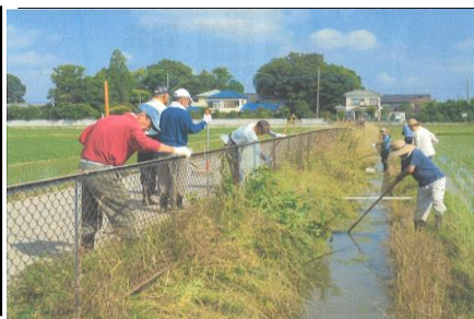
( 水路の泥上げ )
