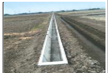
(コンクリート水路への更新)
