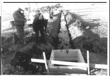
( 水路敷設工事 )
