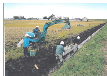
(コンクリート水路への更新)
