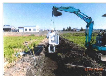
(水路敷設工事 )
