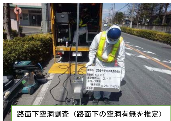
図 4-2 舗装の点検状況例
