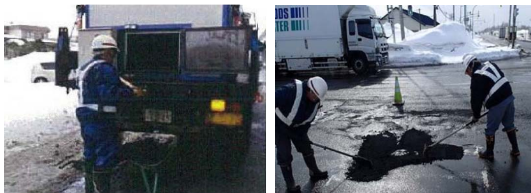
図 3-17 ポットホール補修における新技術の例②（投げ込み補修） 7
