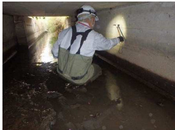
写真 6-2 定期点検の様子（桁下部）
