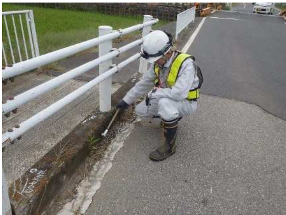
写真 6-1 定期点検の様子（路面）
