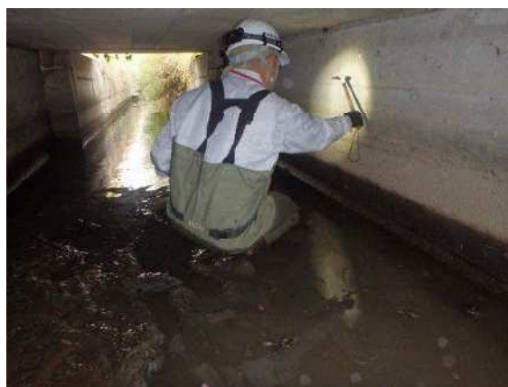
写真 6-2 定期点検の様子（桁下部）
