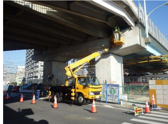
写真 4-1 橋梁点検車による点検(庄内橋) 写真 4-2 リフト車による点検(内谷陸橋)
