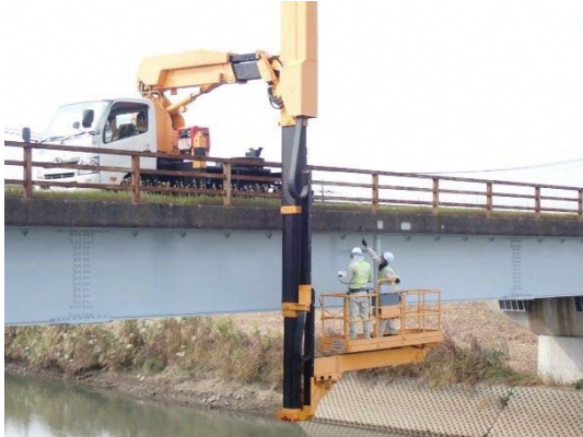
写真 4-1 橋梁点検車による点検(庄内橋) 写真 4-2 リフト車による点検(内谷陸橋)
