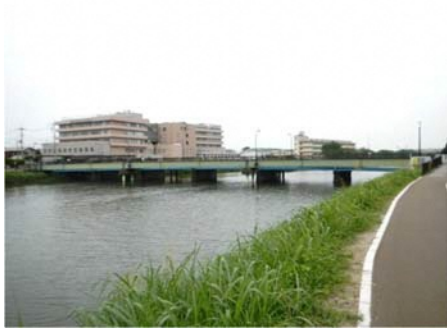
32. 藤塚橋歩道橋（下）
