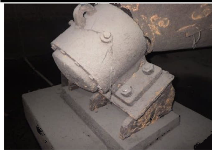
スクリーンプンプ老朽化状況 錆による損傷が進行しており放置すればいずれは脱落の恐れもある
