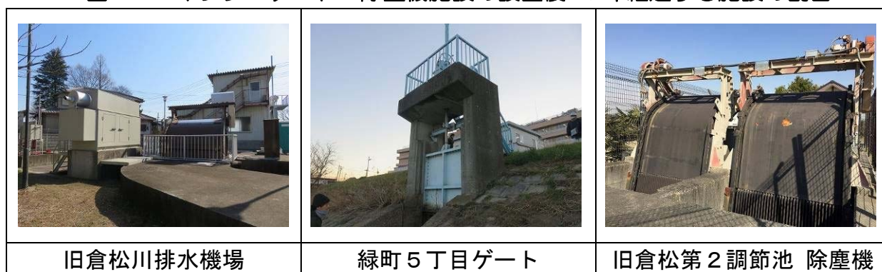
図 2-5 本市のポンプ・ゲート・除塵機施設
