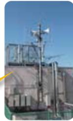
親局から送信した情報を拡声スピーカーから近隣の住民に伝えるとともに、電波を中継し電波不感地域に再送信します。
