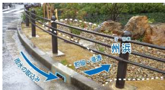
図 31 レインガーデンの仕組み
