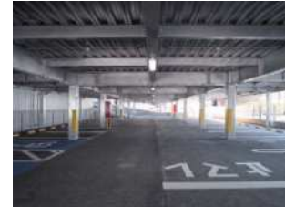
トリアージスペース (立体駐車場棟 1F)
