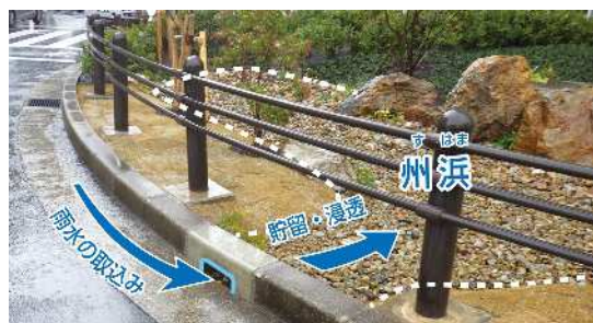
図 31 レインガーデンの仕組み
