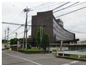
写真④ 北東交差点部外観
