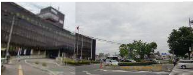
写真① 北側からの外観及び北東部植栽地
