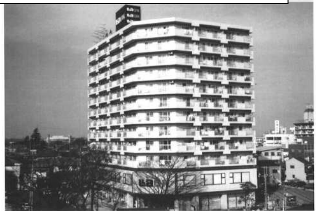
春日部駅東口第6街区第一種市街地再開発事業 完成写真
