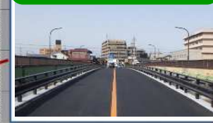
橋りょう 長寿命化修繕事業
