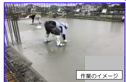
左官(コンクリート均し)工事
