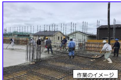
コンクリート工事
