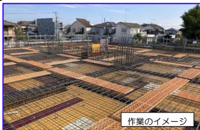
建物屋上梁・床配筋工事
