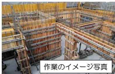
建物1階の鉄筋・型枠工事
