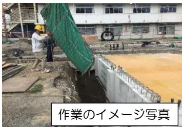
土（基礎外周部埋戻し）工事
