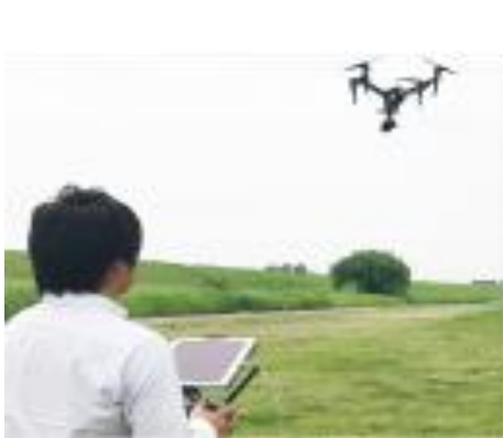
ドローンを使った起工測量
