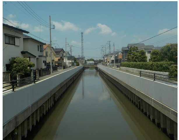
100 mm/h 安心プラン (安之堀川護岸改修の様子)
