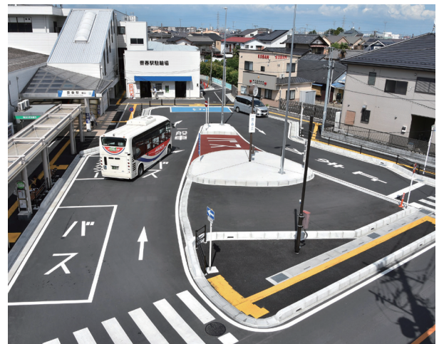
豊春駅東口駅前広場整備工事後のロータリー
