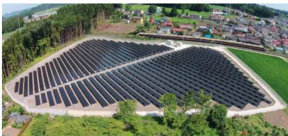
栃木県日光市 太陽光発電所 1,044kW 当社施工
